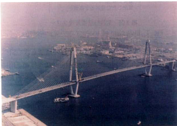
第1図 「名港中央大橋」 Fig. 1 “Meiko central bridge”
